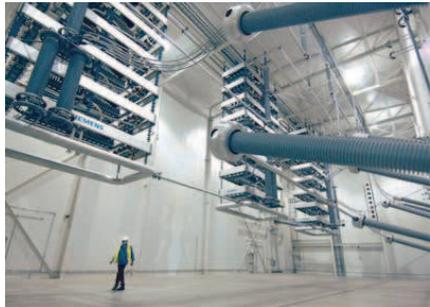
Hochspannungs-Gleichstrom-Übertragung, Umrichterstation, 500 MW, 400 kV
