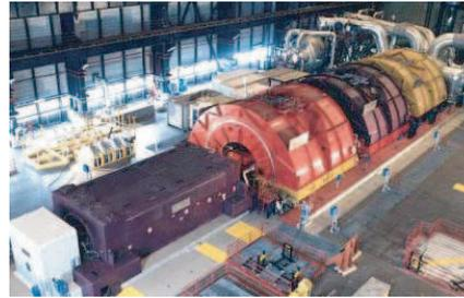
Turbogeneratoren (vorne links) sind die bedeutendsten Stromquellen der öffentlichen Energieversorgung.
