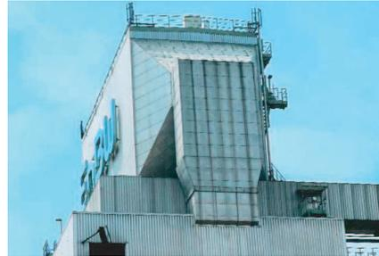
Elektrostatischer Filter zur Abgasreinigung des Heizkraftwerks Stuttgart-Münster
