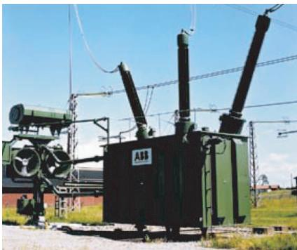
Drehstromdrossel zur Blindleistungsaufnahme 150 MVA, 400 kV
